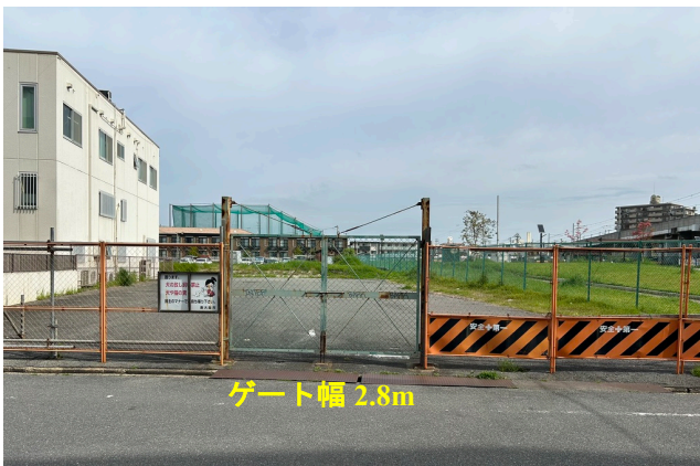
(1) 敷地の入口ゲート
