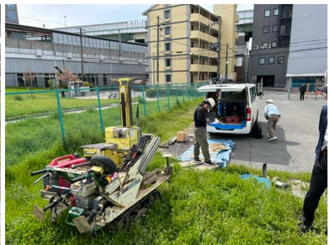
(6) 盛土上での SWS 試験状況
