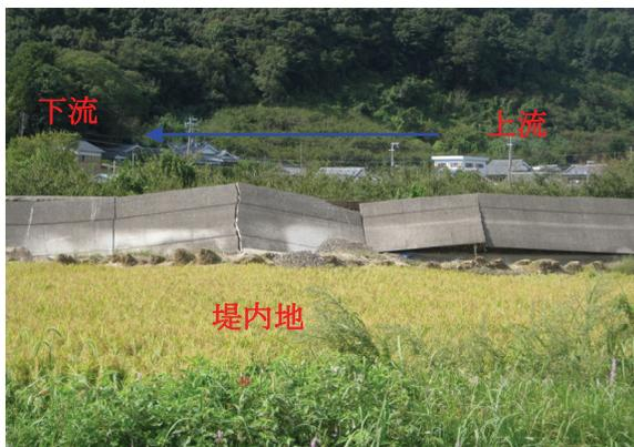
写真3.3.3 コンクリート被覆損壊 (写真③)
