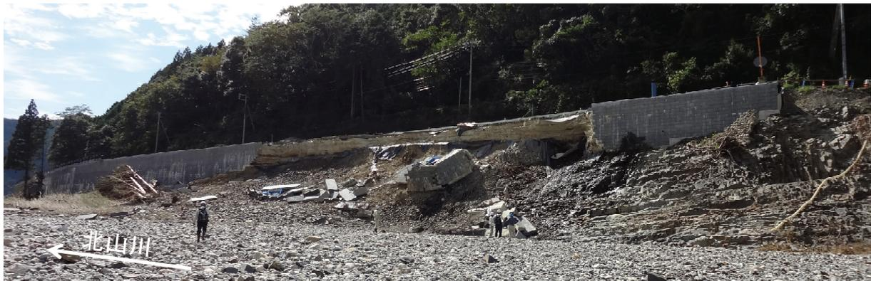
写真 5.8.6 護岸兼用軽量道路盛土の崩壊箇所全景(下流側)
