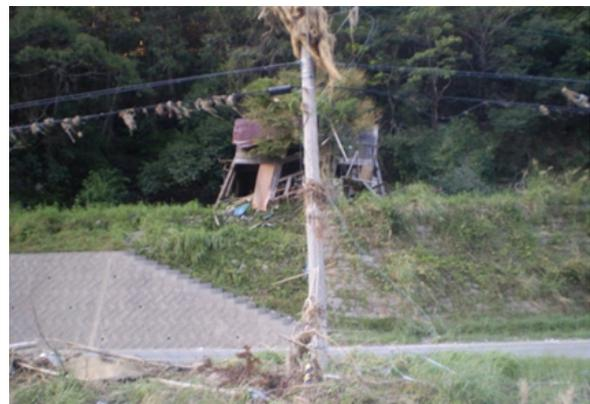
写真 5.6.2 高所に残る漂流物と小屋の倒壊
