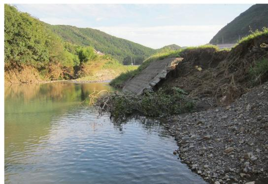
写真3.3.18 崩壊1護岸被災状況(写真⑪)
