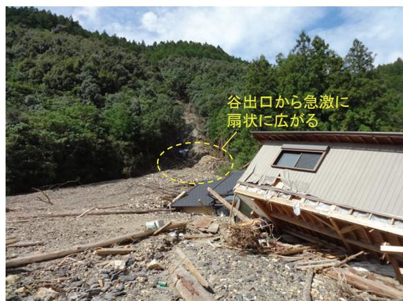
写真 5. 8. 2 斜面全景と家屋倒壊状況
