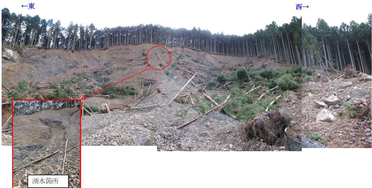
写真 4. 14. 5 崩壊部全景および湧水箇所
