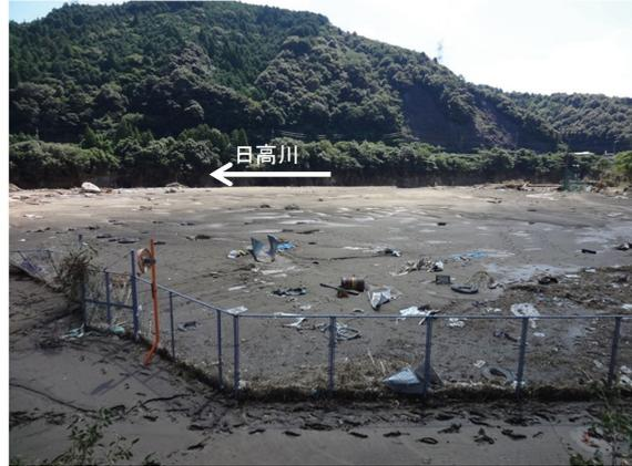
写真3.1.5 湾曲部内側高水敷の駐車場の土砂堆積(写真④)
