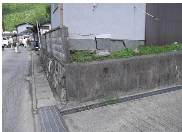
写真 4.5.6 水没家屋基礎部 (実質全壊状態)
