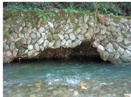
写真3.4.2 合谷川左岸水衝部の損傷
