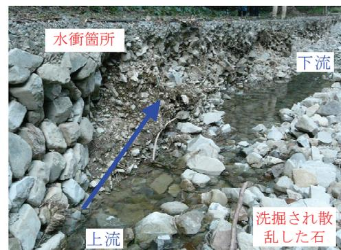
写真3.4.3 合谷川左岸の損壊(その1)
