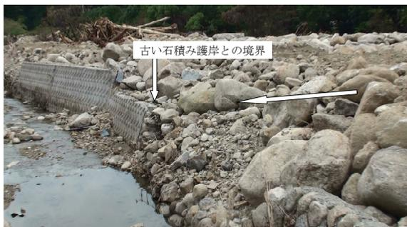
写真6.9.2 護岸損傷部(コンクリート護岸の一部は残っているが、古い石積み護岸は大部分流出)
