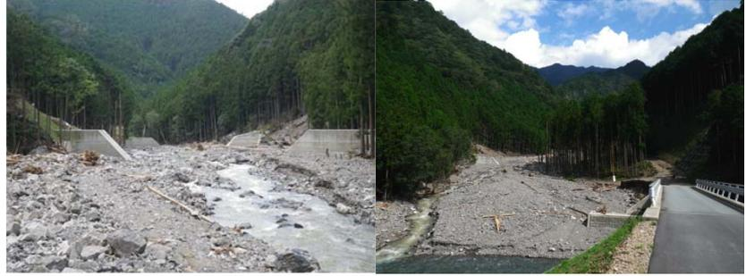
図-35 堰堤への土石と下流の状況
