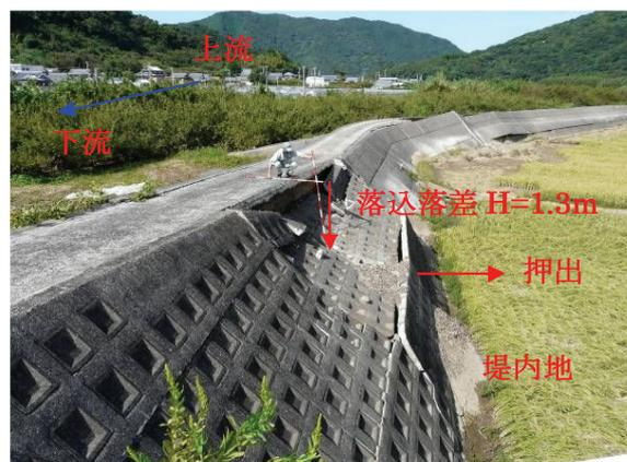
写真3.3.2 張りブロック被覆損壊 (写真②)
