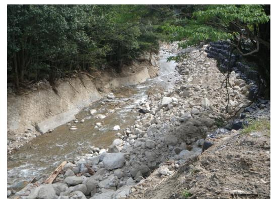
写真 6.4.8 浸食による護岸基礎部の洗掘
