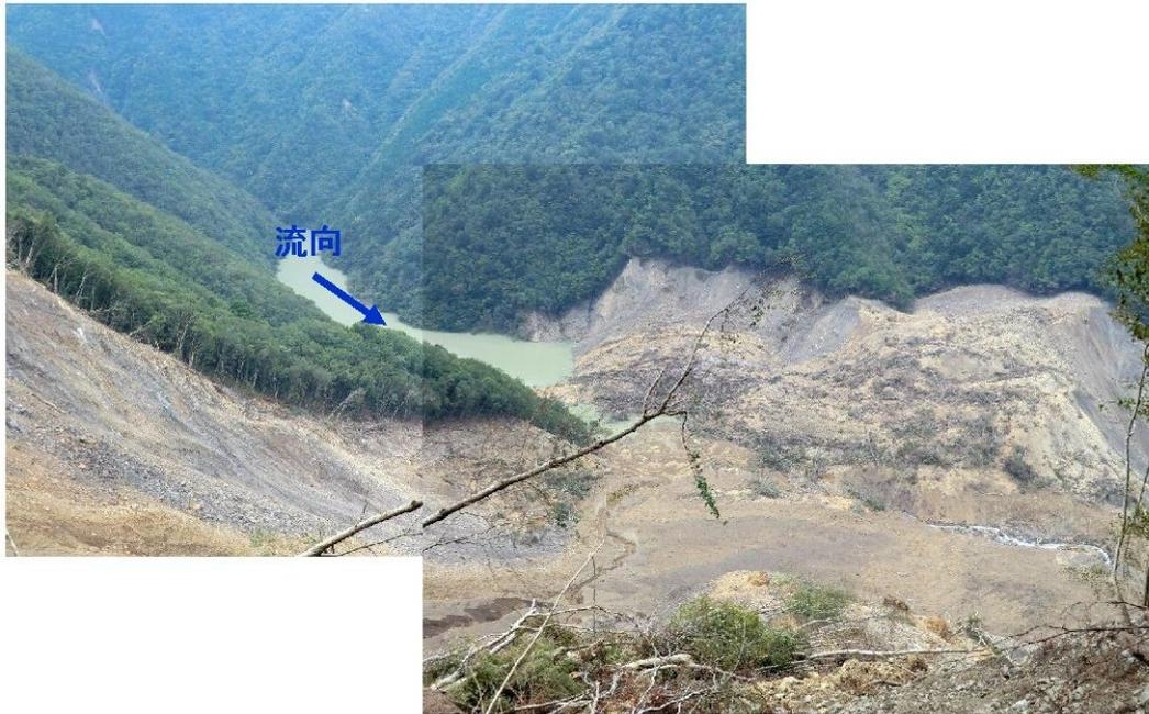
写真 4. 9. 6 河道を埋積した崩積土砂と堰止め湖
