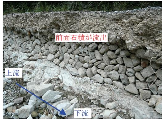
写真3.4.5 合谷川左岸の損壊（その3）
