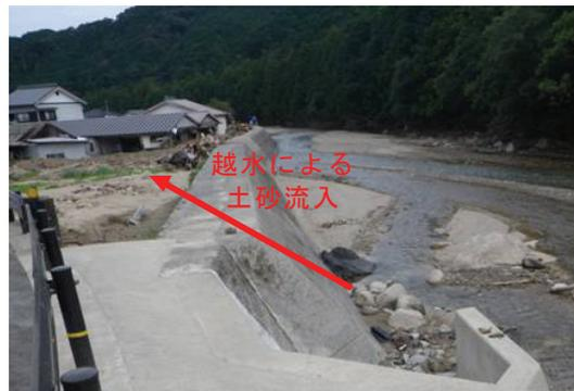
写真6.12.2 越水による土砂流入
