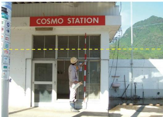
写真 5.5.1 ガラス窓に残る水位(黄色破線)
