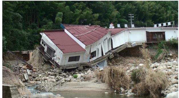
写真6.7.1 護岸の洗掘による建物の被害
