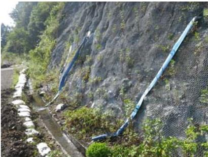
図-14 水抜き工の状況
