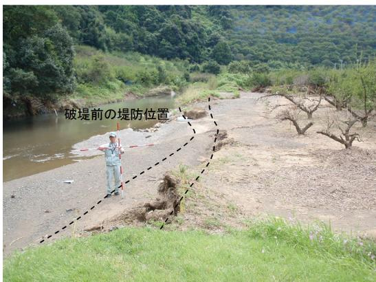
写真3.2.2 土堤決壊部全景(上流より)
