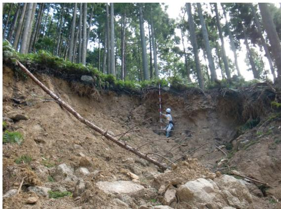
写真 5.2.1 崩壊跡①(幅 13m×奥行 60m, 手前は棚田の石積も崩壊している)
