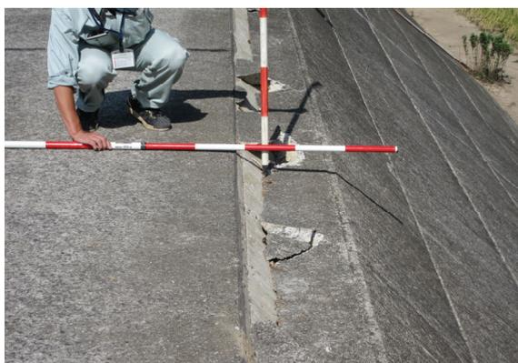
写真3.3.5 コンクリート被覆ズレ (写真⑤)
