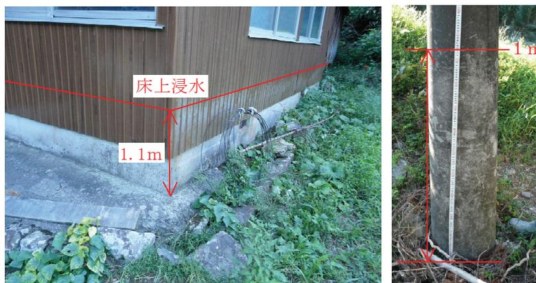
写真3.4.6 合谷川下流での床上浸水
