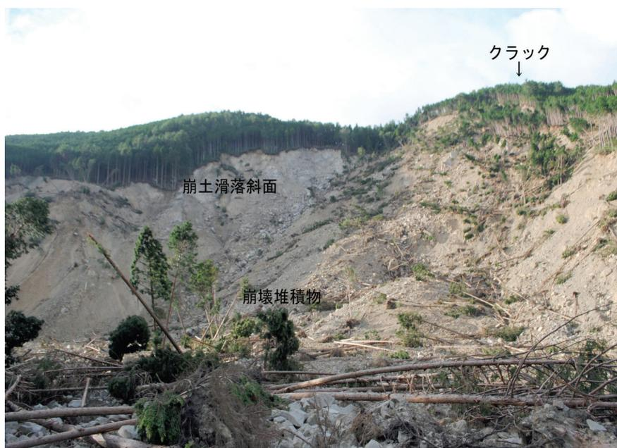
写真4.5.2 崩壊部全景(崩壊部右上方には尾根近くまで多数のクラックが発達する)
