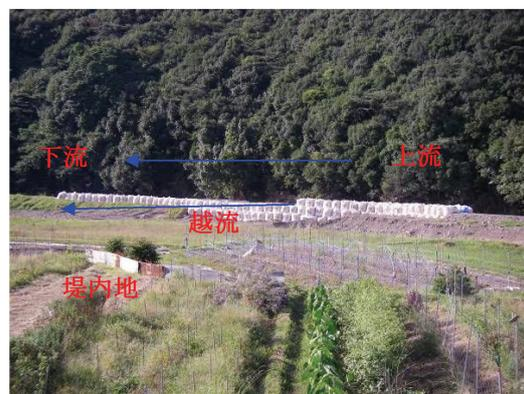
写真3.3.8 被災1堤防損壊状況(写真②)
