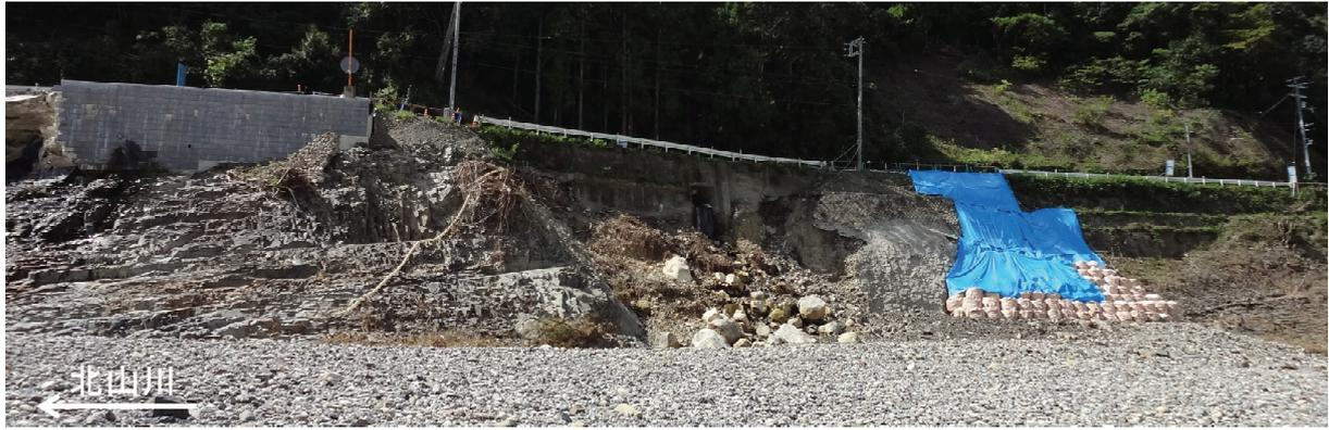
写真 5.8.7 護岸兼用軽量道路盛土の崩壊箇所全景(上流側)
