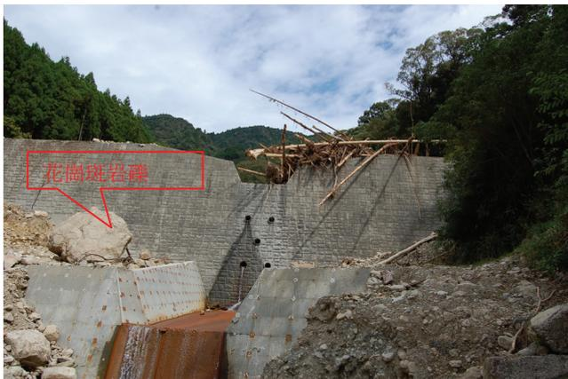
写真6.5.4 支沢b砂防堰堤の流木堆積状況(手前は堰堤を越えた花崗斑岩の巨礫)
