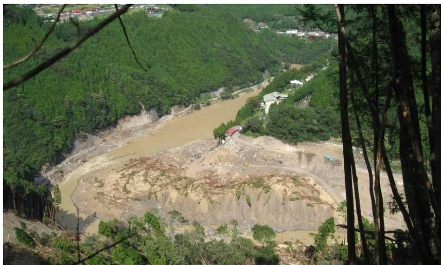
写真 4.7.3 対岸における崩積土の堆積状況
