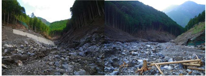
図-49 河川の堆積，浸食の状況
