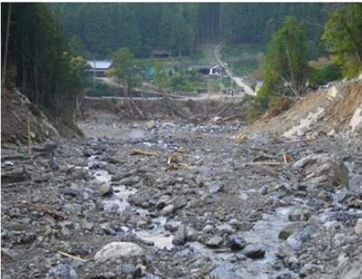
図-44 堰堤付近の浸食と土石の状況
