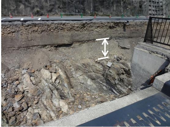
写真3.1.4 露出した河川改修前の石積み護岸(写真③)
