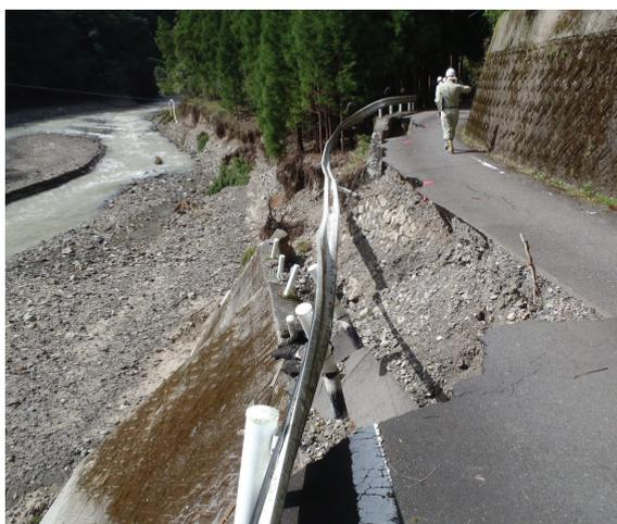
写真 5.9.7 下流ブロック積護岸の崩壊と道路の被災
