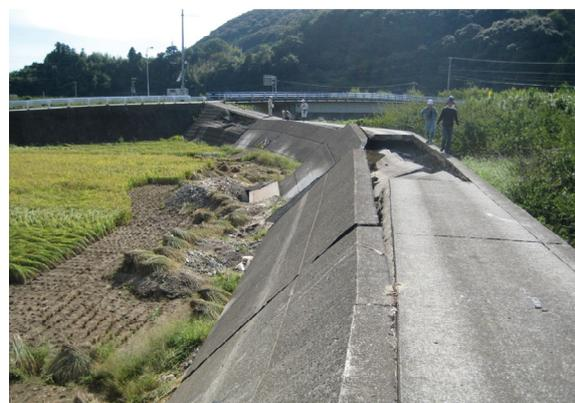
写真3.3.4 コンクリート被覆損壊 (写真④)
