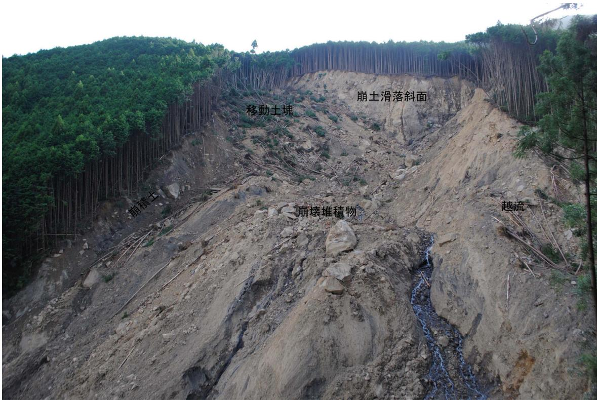
写真4. 2. 2 崩壊部と移動土塊及び直下の崩壊堆積物
