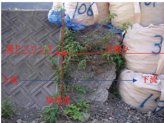
写真3.3.7 被災1堤防損壊状況(写真①)
