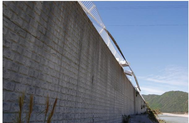
写真 5.7.4 擁壁前面の様子(変状なし)
