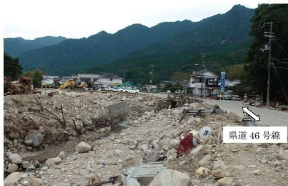
写真6.9.1(b) 土石流による護岸の被害
