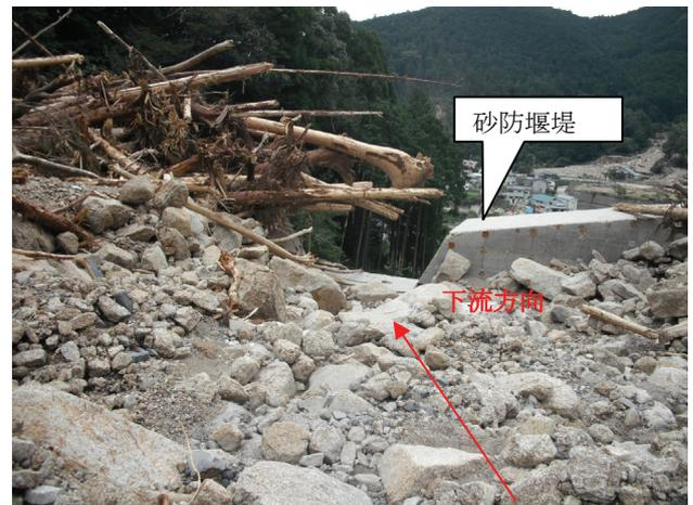
写真6.5.5 砂防堰堤背後の状況(満砂)
