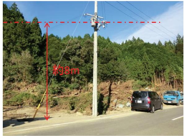
写真 5.3.8 電柱に付着した水位痕跡
