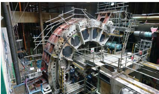
解体中のシールドマシン
