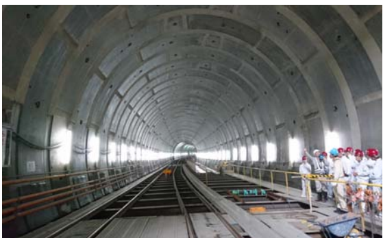
シールドトンネル
