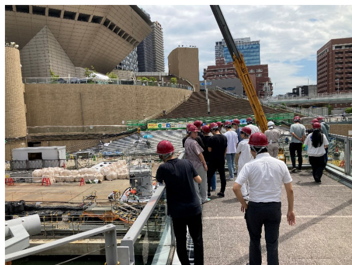
写真-2 現場見学の様子
