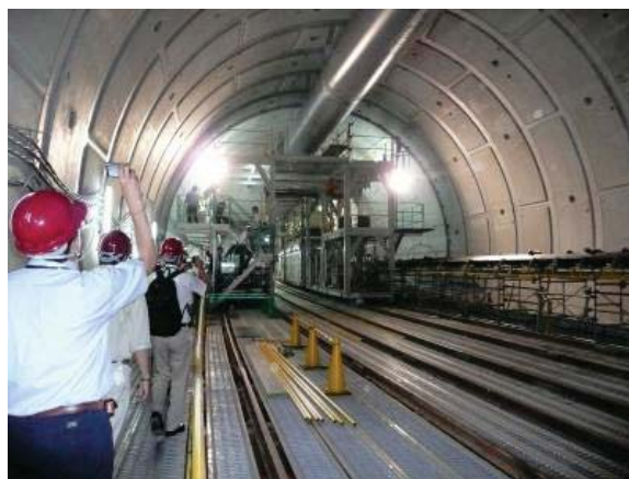
シールドトンネル工事の見学状況 (H25年度)
