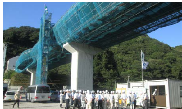
写真-4 十九淵高架橋上部工事
