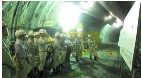
写真-2 周参見第二トンネル工事
