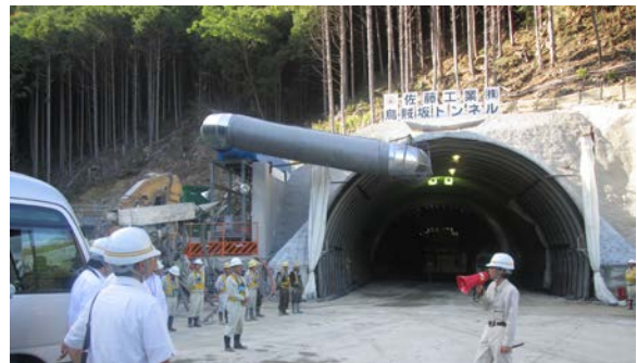
写真-3 烏賊坂トンネル工事
