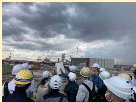
開削工事箇所見学
