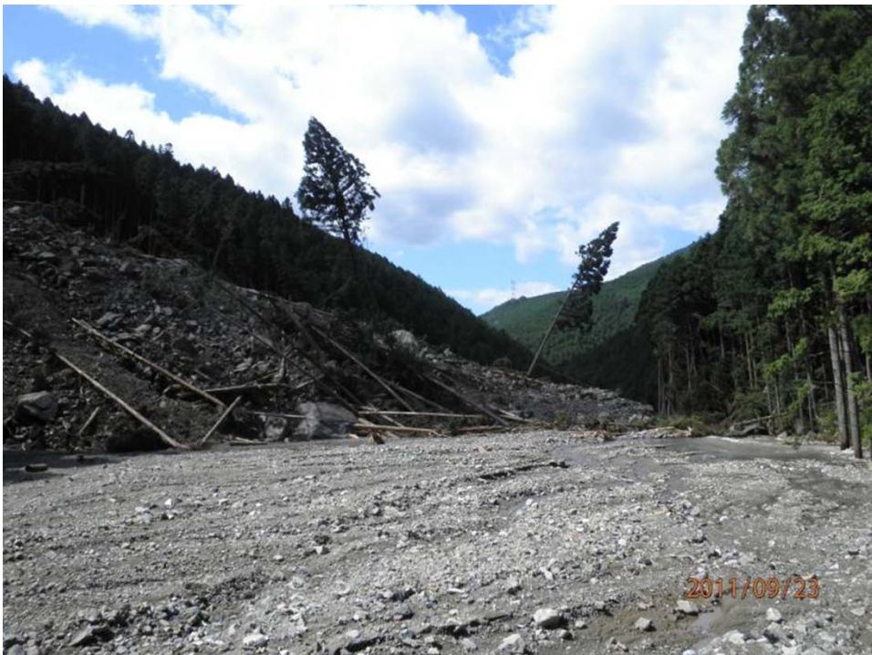
崩壊土砂が川を埋めている様子
