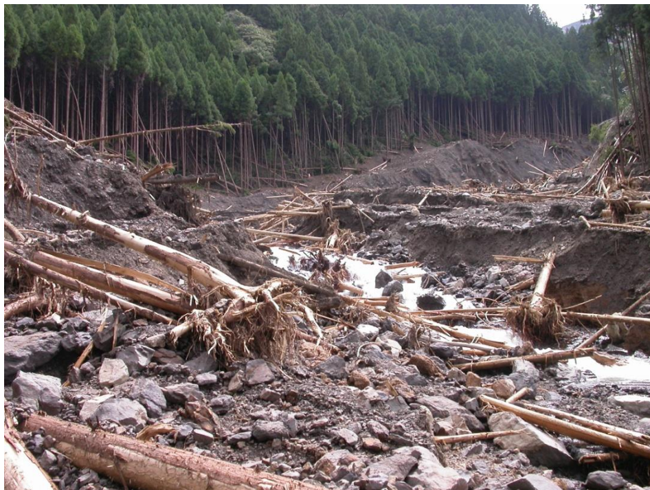
崩落斜面の下流部谷底から 崩落斜面对岸に土砂の乗り上げ跡が認められる。 足下は崩落土石流の堆積物
