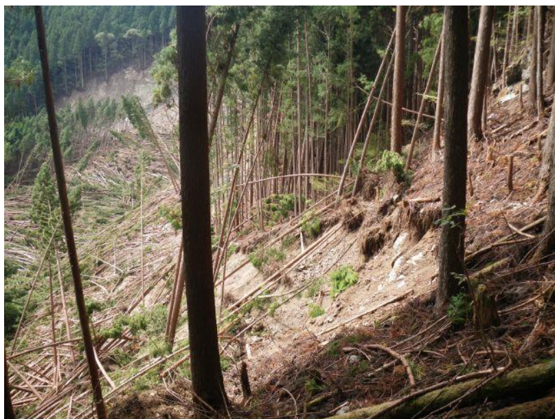
滑落崖の状況 滑落崖には旧崩積土が分布している
