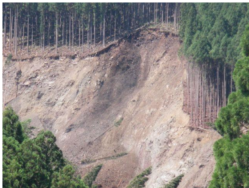
滑落崖の状況 滑落崖の拡大が認められる
