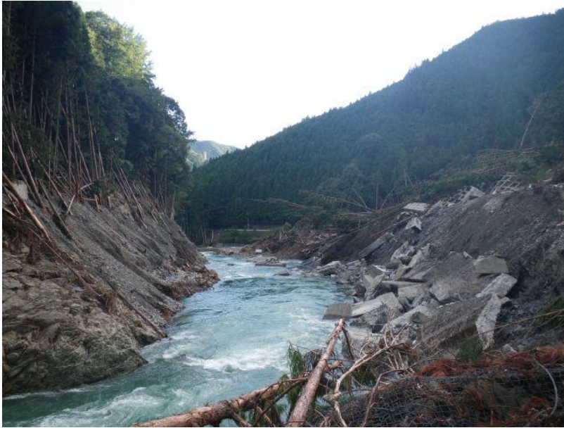
崩壊地末端部 県道沿いの護岸工や法枠工は滑動土塊により約100m押し出されている 法枠工は比較的形狀を留めている
