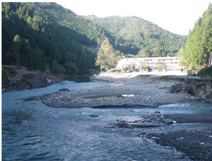
斜面对岸の洗掘状況 洗掘により中学校グラウンドや村道は崩壊している
