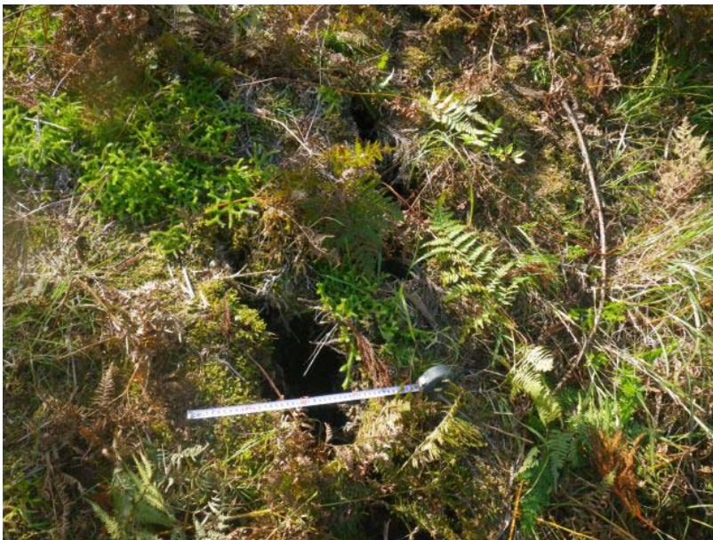
滑落崖上方の地表面の開口亀裂 開口幅0.1~0.2m程度
