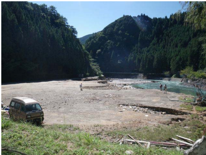
斜面对岸の中学校グラウンド 滑動土塊により天ノ川の流路が変わり、対岸が洗掘を受けた
