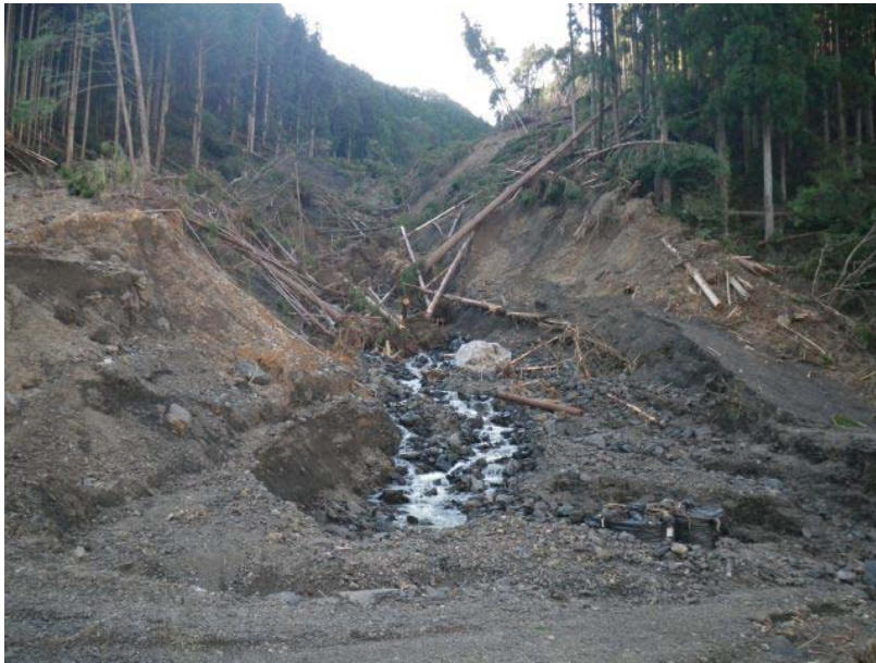
崩壊地末端部の状況 流水により大きく洗掘を受けている
