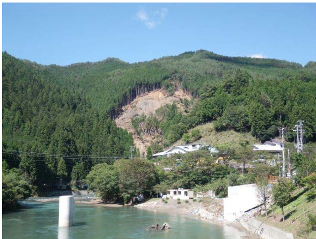
アシノセ谷崩壊地の全景
