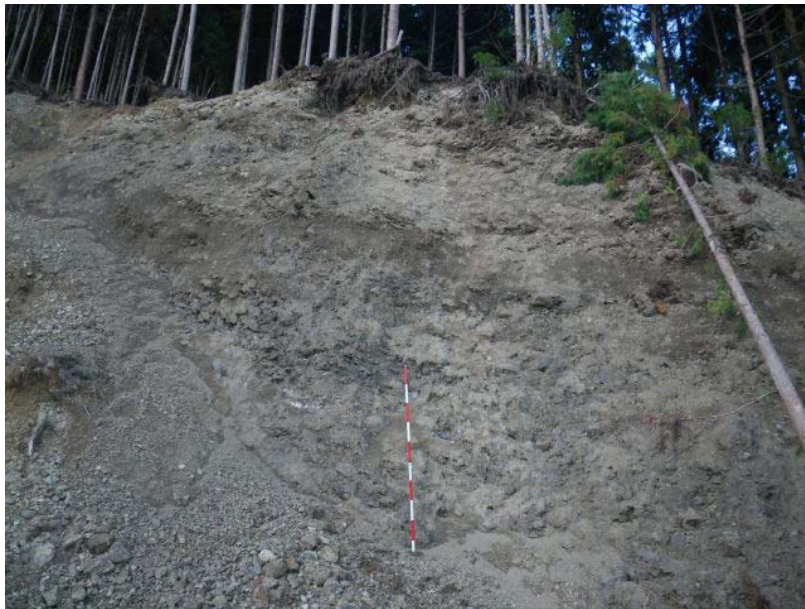
滑落崖の状況 滑落崖には旧崩積土が分布する
