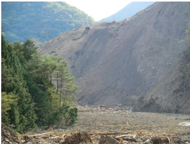
写真 4. 9. 7 下流から見た土砂ダム
