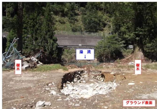
写真 4.4.4 天川中学グラウンド表面の洗
