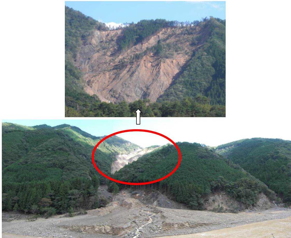
写真 4. 10. 2 国道 168 号から見た全景と崩壊部の拡大写真
