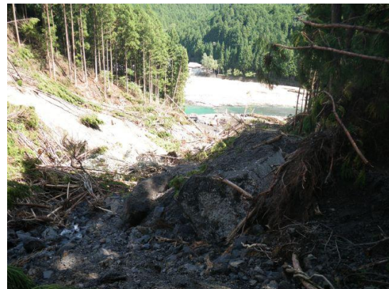
写真 4.1.4 崩壊地内の状況
