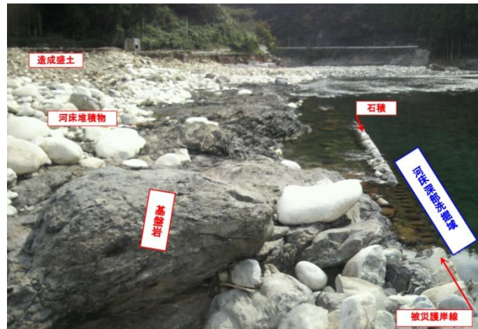
写真 4.4.2 洗掘状況詳細 10月7日
