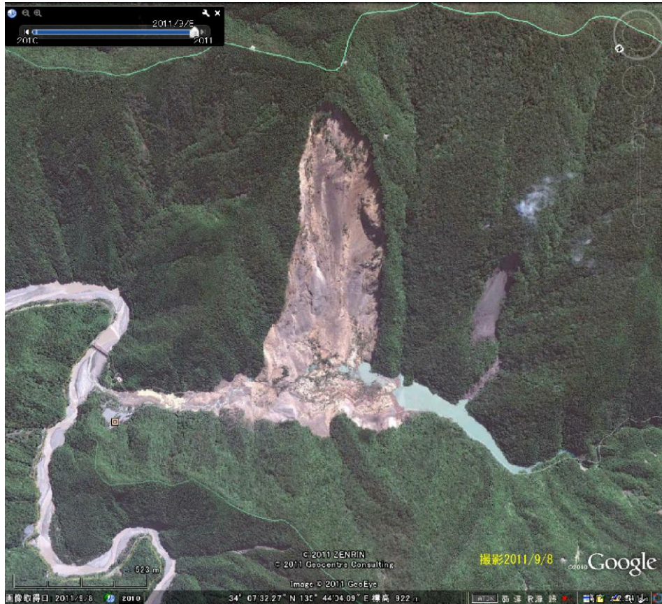
写真 4.9.1 崩壊前後の空中写真 (Google 画像を使用)
