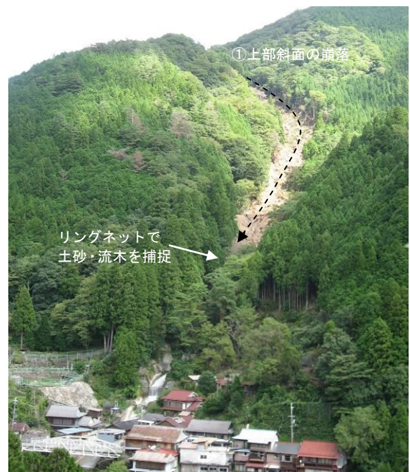
写真 4.6.1 対岸よりの崩壊地全貌（柳谷）
