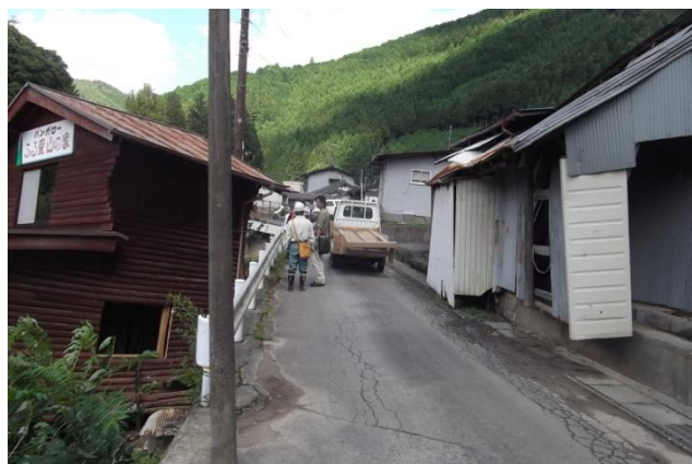
写真 4.5.5 完全水没全壊状態の建物群
