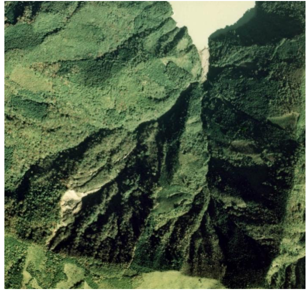
(崩壊前，1976年6月撮影)
