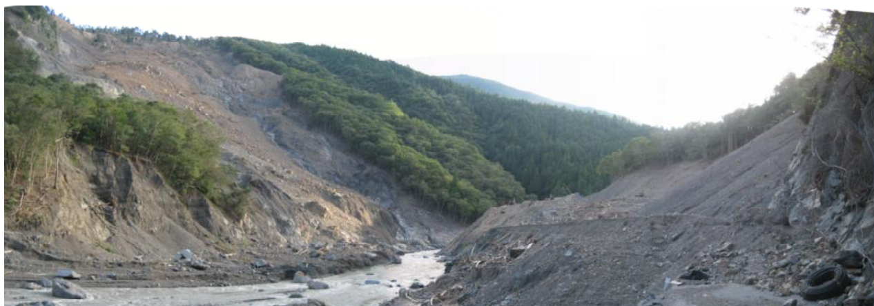
写真 4.8.2 左岸下流から見た崩壊地（左）と対岸の土砂堆積（右）
