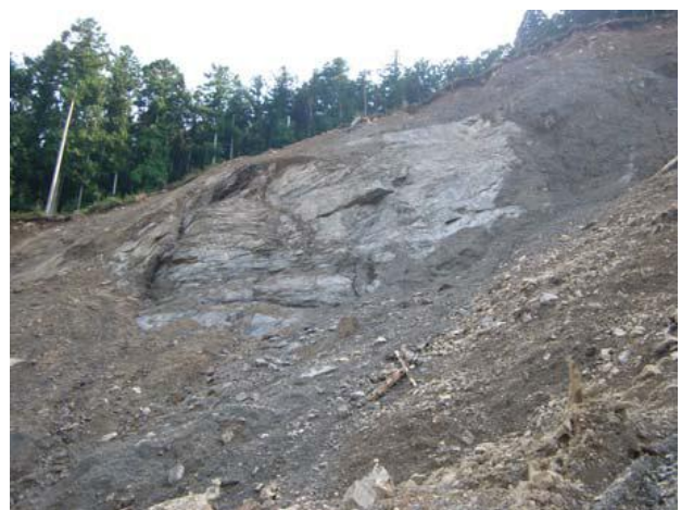
写真4.15.7 崩壊崖面の岩盤状況
