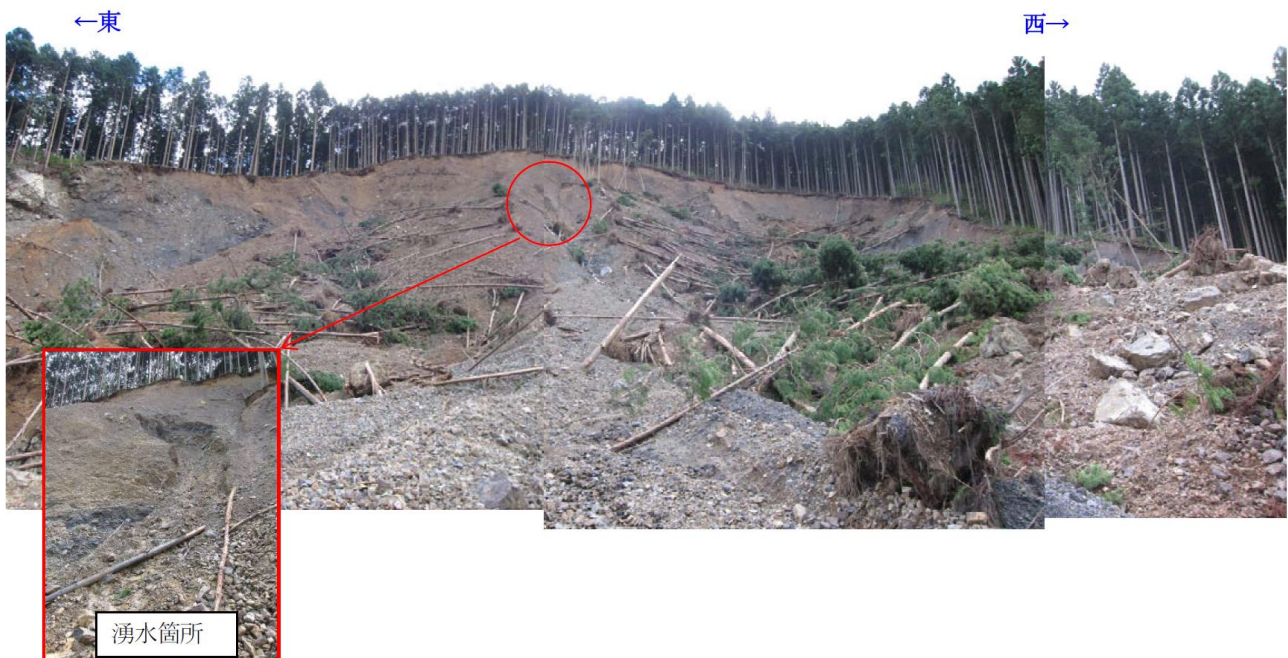
写真 4. 14. 5 崩壊部全景および湧水箇所
