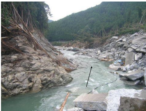
写真 4.3.6 滑動土塊末端部の状況
