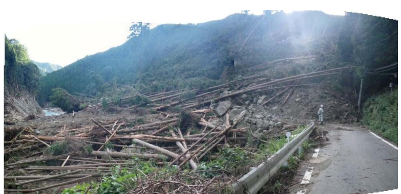
写真 4.3.5 斜面末端部の状況 県道は崩落・寸断されている。
