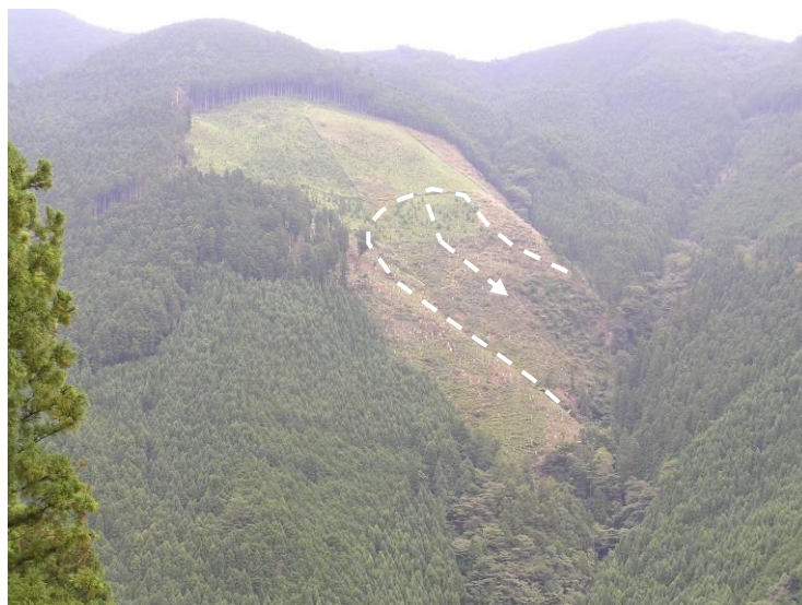
写真 4.6.5 崩壊前の地形（鍛冶屋谷，2007 年 5 月撮影）
