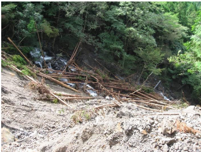
写真 4.6.3 リングネットで捕集された土砂（柳谷）
