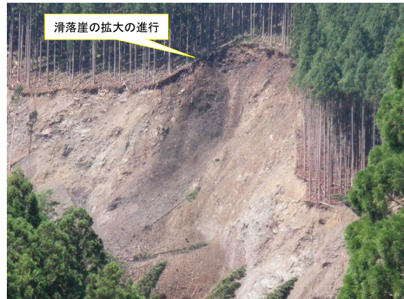
写真 4.3.3 滑落崖の崩壊
