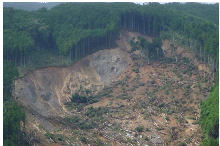
写真 4.15.2 崩壊地の上部の状況
