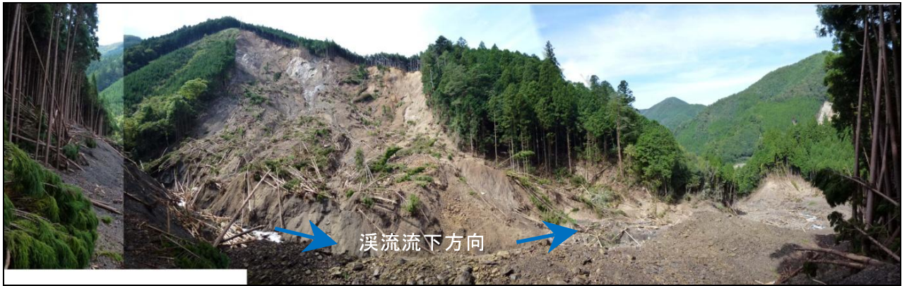
写真 4. 12. 1 崩壊地全景（溪流対岸からの眺望）
