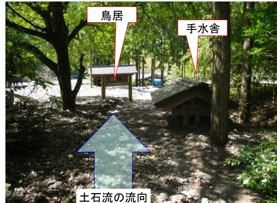
写真 4.2.7 禊殿付近の状況
