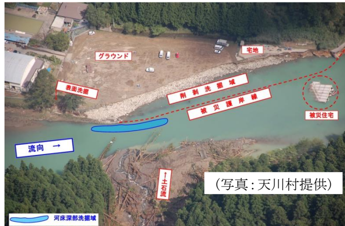
写真 4.4.1 天川中学校洗掘状況 9月6日
