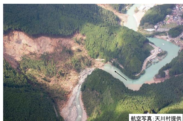
写真 4.3.9 滑動土塊による川の堰止め
