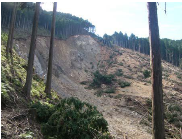
写真4.15.6 崩壊地の中央部崖面にみられる岩盤
