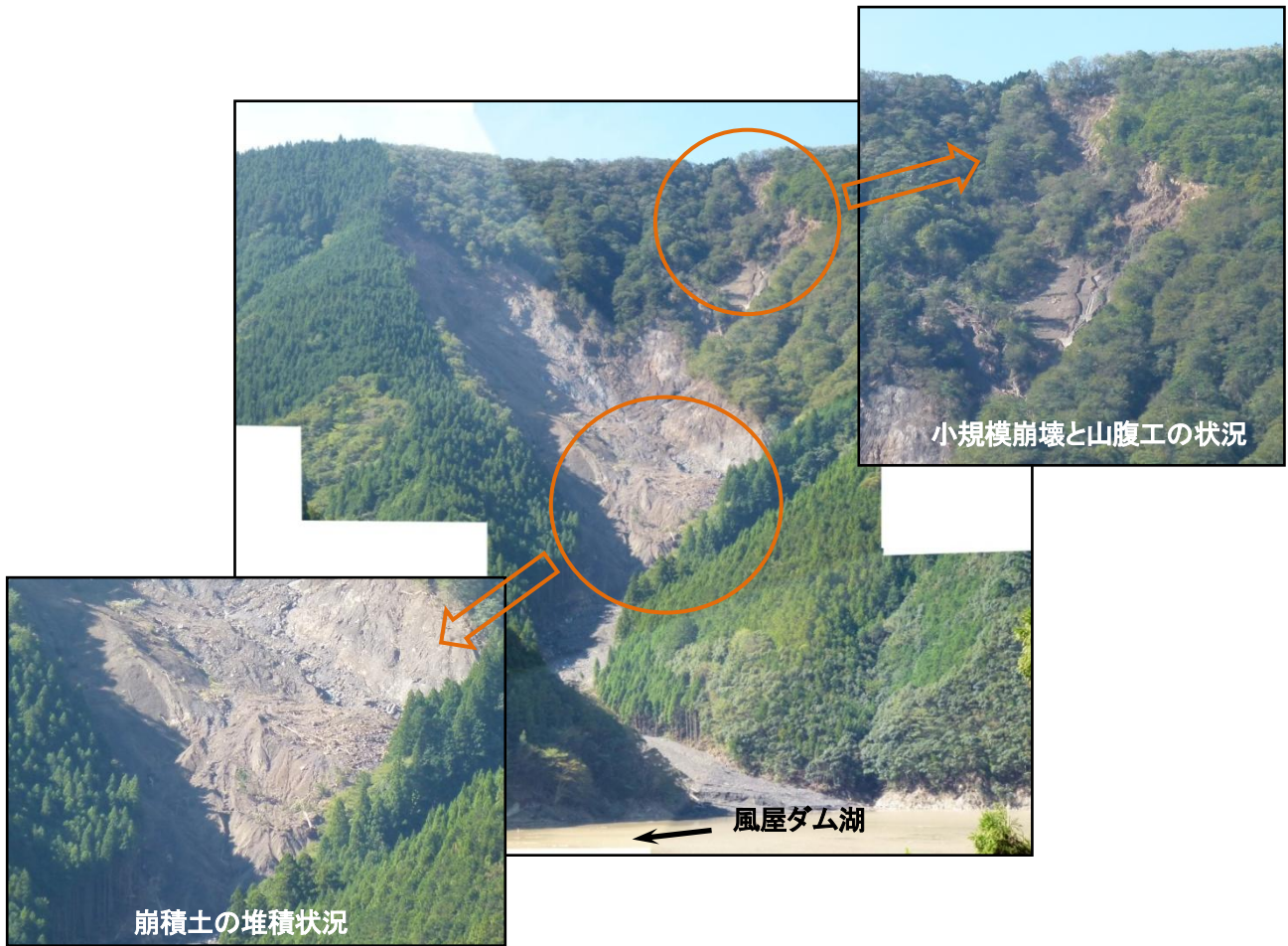
写真 4.11.1 崩壊地全景（風屋ダム湖対岸からの遠望）
