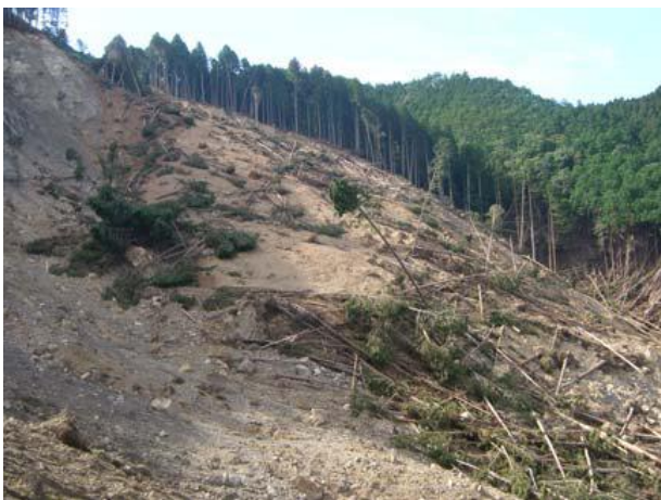
写真 4. 15. 4 崩壊地北側の斜面状況
