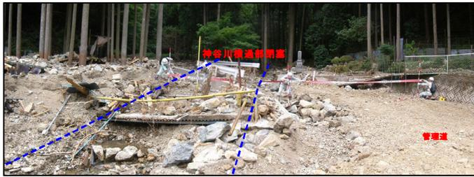
図 3.43 流路工閉塞状況<sup>4)</sup>
