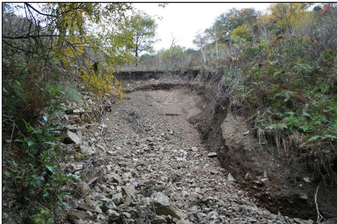
図 3.52 支流源頭部斜面崩壊状況（撮影方向⑫）
