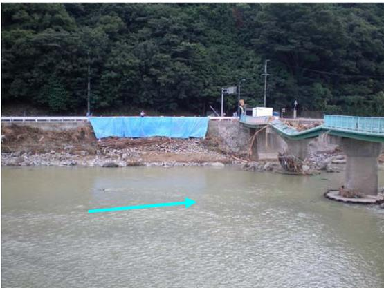
図 2.12 橋梁上流側護岸被災状況
