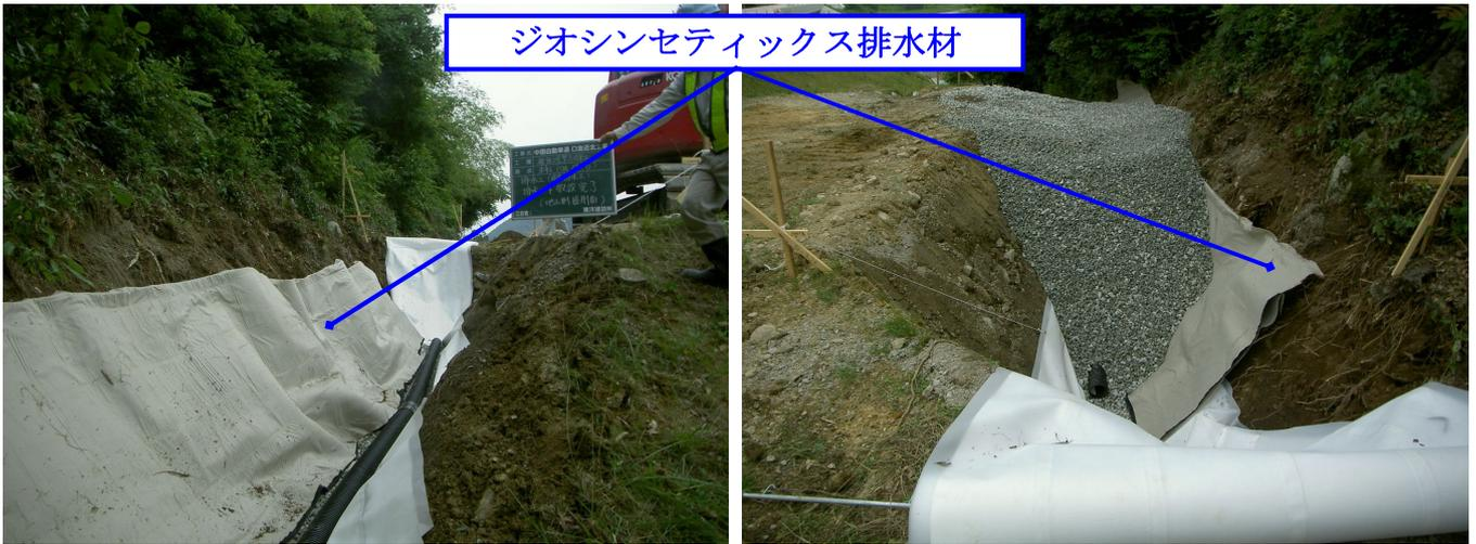
図 4.38 排水対策工の施工状況
