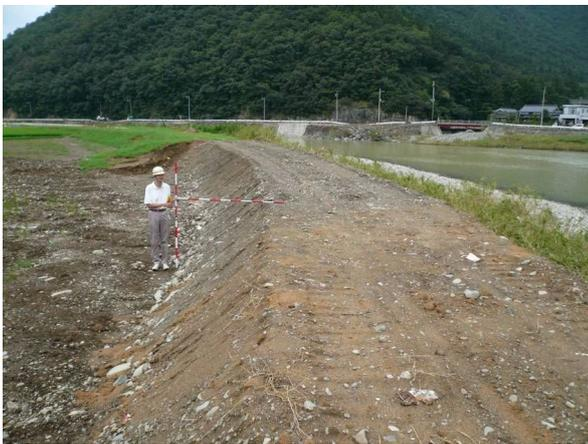
図 3.1 堤防被災箇所（土堤部）
