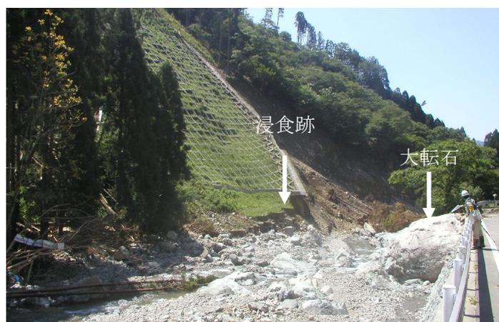
図 3.29 流水による浸食状況（上流側）
