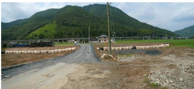
図 3.7 暫定堤防の被災状況
