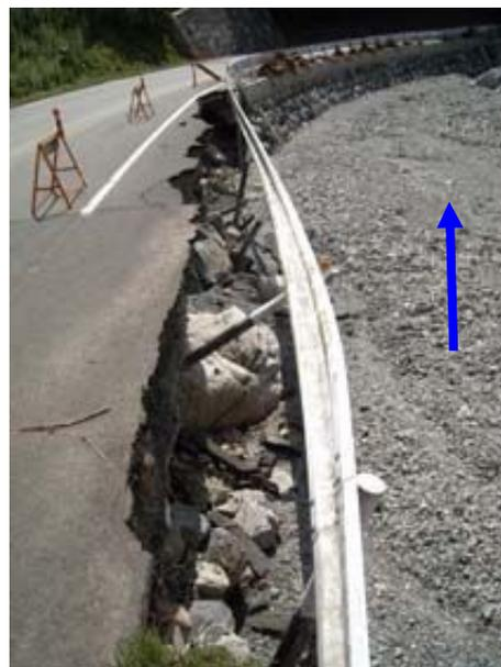
図 2.70 護岸損傷状況
