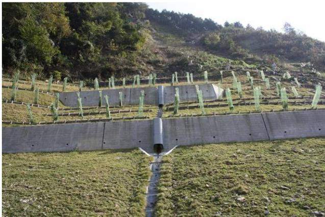
図4.14 コンクリート土留工と水路工
