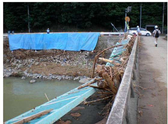
図 3.8 取付護岸の被災
