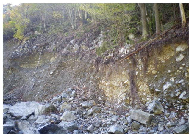
図 3.30 流水による浸食状況（下流側）
