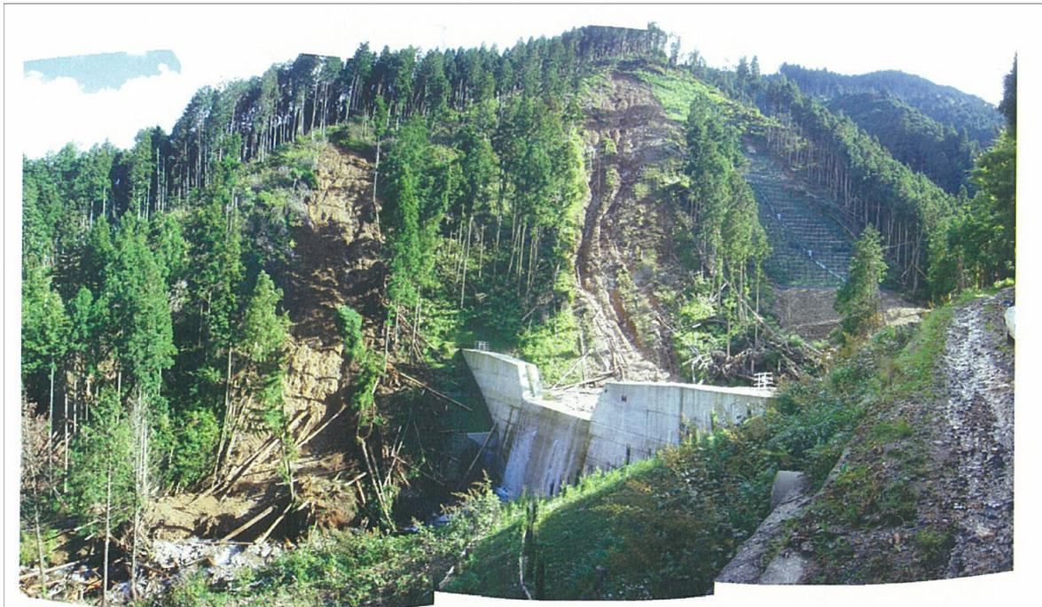
図 4.6 斜面下部から眺めた谷止工，山腹工と崩壊地の状況<sup>4)</sup>
