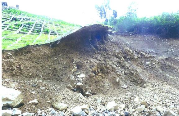
図 3.32 法枠工下部の地盤の抜け落ち状況<sup>4)</sup>
