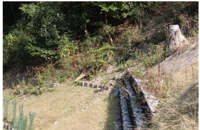
図4.15 鋼製枠土留工
