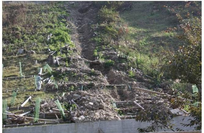
図 4.23 崩壊地下部の流出状況
