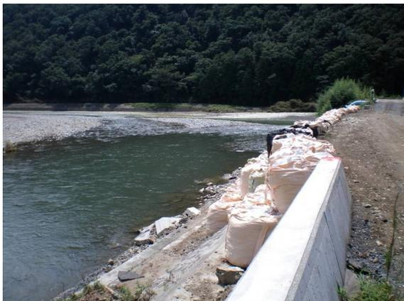
図 3.17 パラペットの川側への崩落
