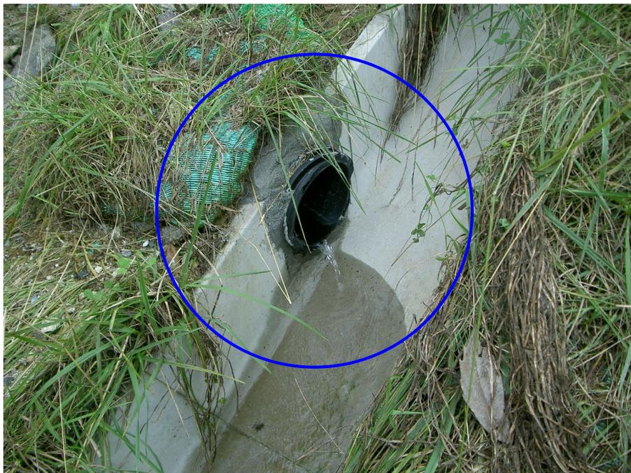
図 4.40 排水対策工の流末
