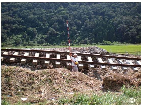
図 2.34 線路の被害状況
