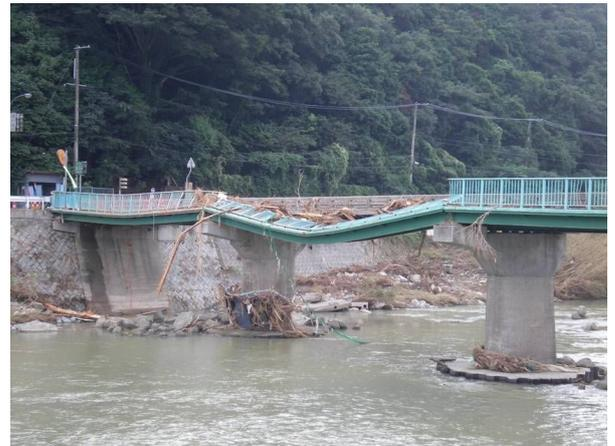
図 2.11 橋梁の損壊状況
