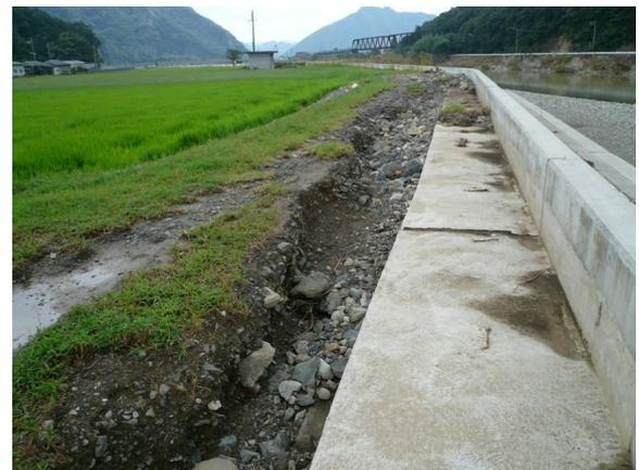
図 3.3 堤防被災箇所（パラペット部）
