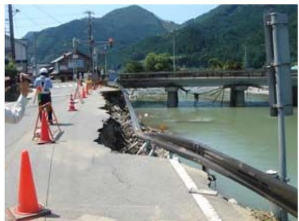
図 1.5 橋梁上流側の護岸被害
