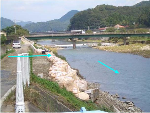
図 2.24 護岸背面からの外力による被災
