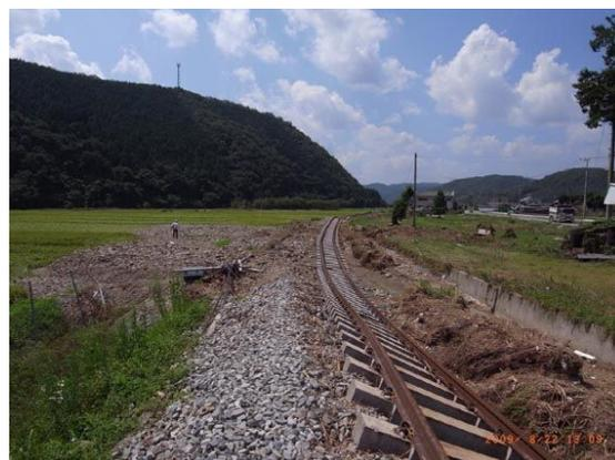
図 2.35 線路の被害状況
