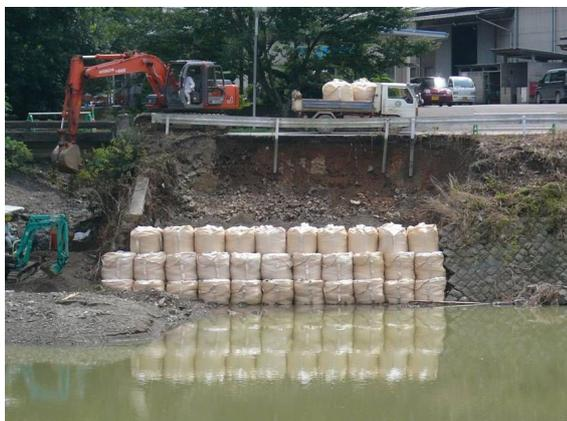
図 3.13 石積護岸被災箇所
