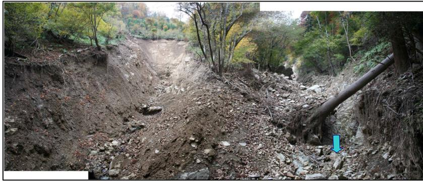
図 3.49 上流部における大規模斜面崩壊状況（撮影方向⑨）
