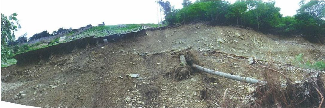
図 3.31 法枠工の被災状況<sup>4)</sup>
