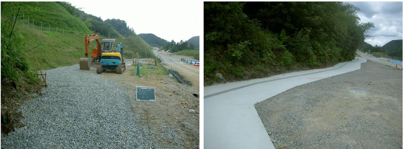
図 4.39 排水対策工施工完了
