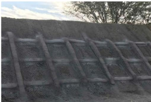
写真-5 吹付枠施工完了
