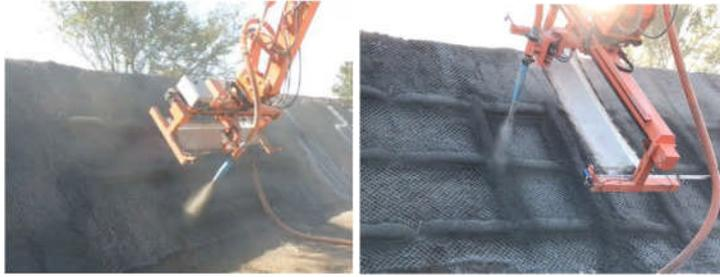
写真-3 のり砕吹付状況 (左: 横枠、右: 縦枠)
