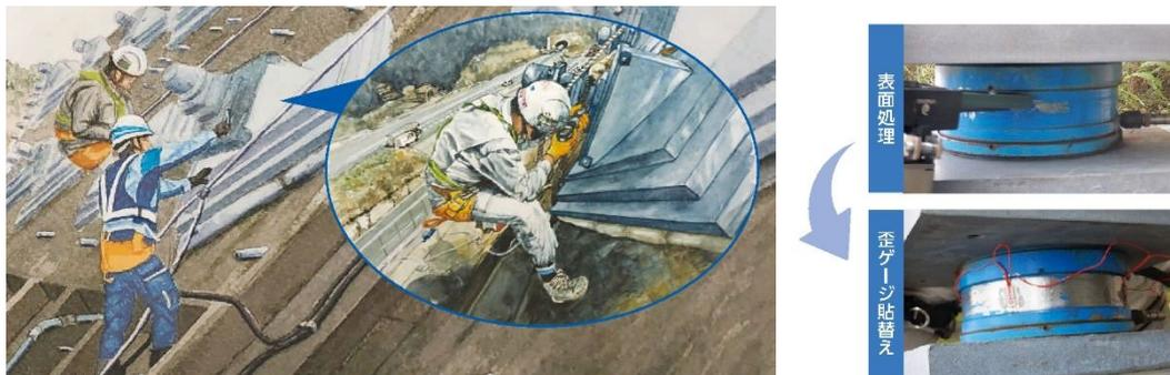
図-2 現場での補修再生方法実施状況
